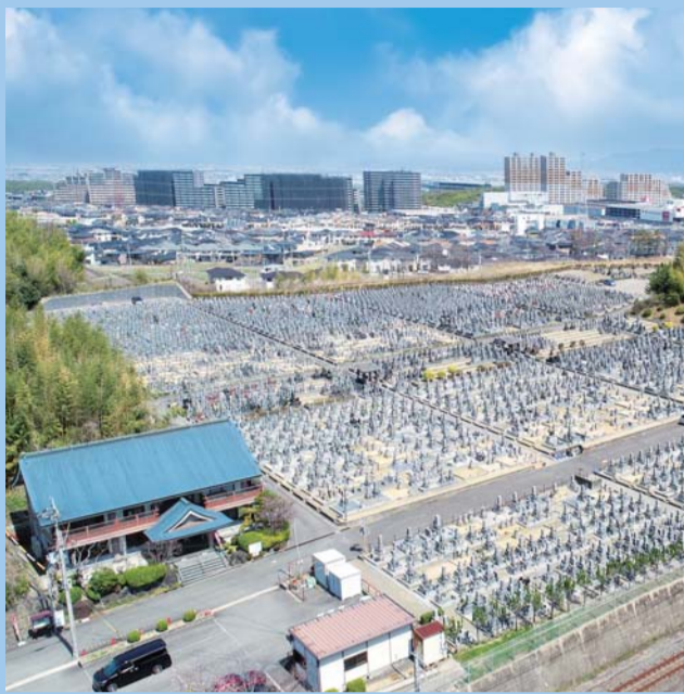
設備が充実、管理棟
